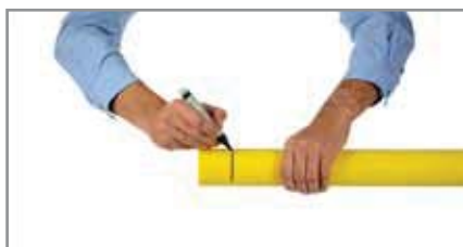
7. Marcar a profundidade de inserção do tubo.
