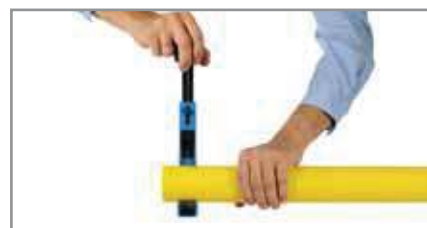
3. Cortar o tubo de forma totalmente reta.
