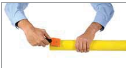
5. Raspar a zona de soldadura do tubo.
