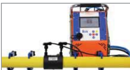
11. Início da soldadura.
